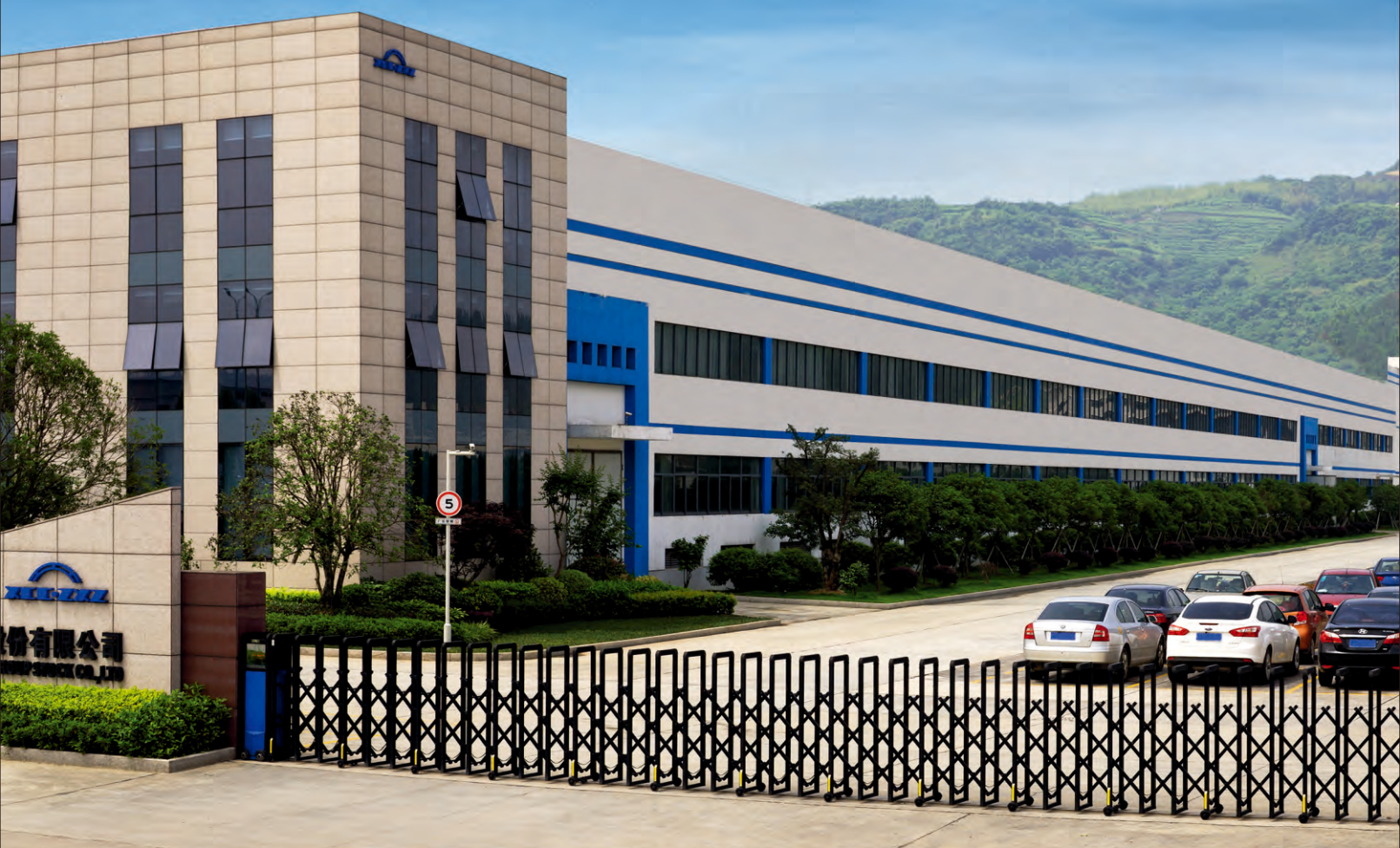
南岩工业园区
